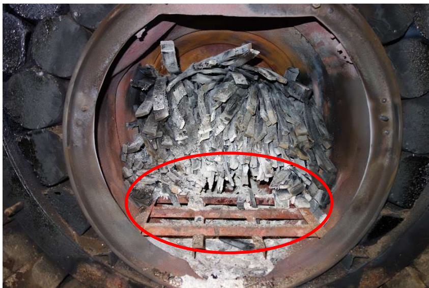
絞った煙道に向けて空間(トンネル)が出現
