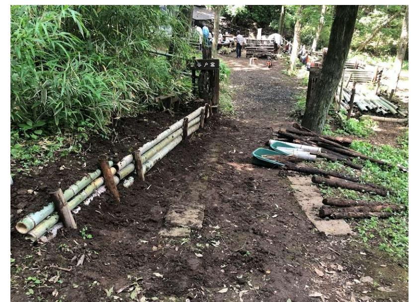
木製の土留めを竹製に変更して施工
