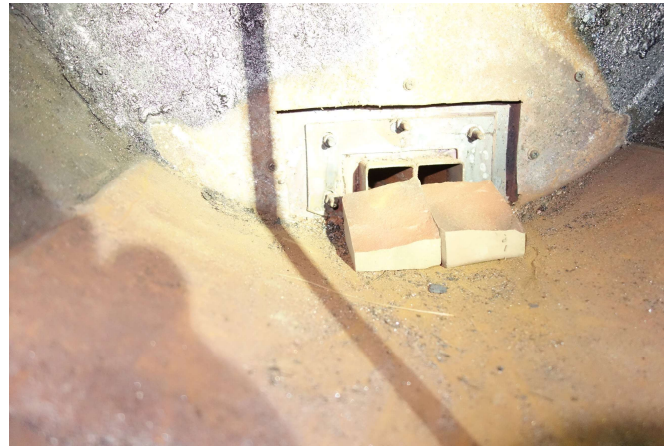
レンガを置いて、煙道入口高さを40mmから19～20mmに絞り込む(詳細、次ページ)
