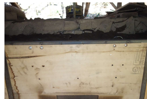
土留め板も分割し、1人でも取り付けられるよう軽量化織り込んだ
