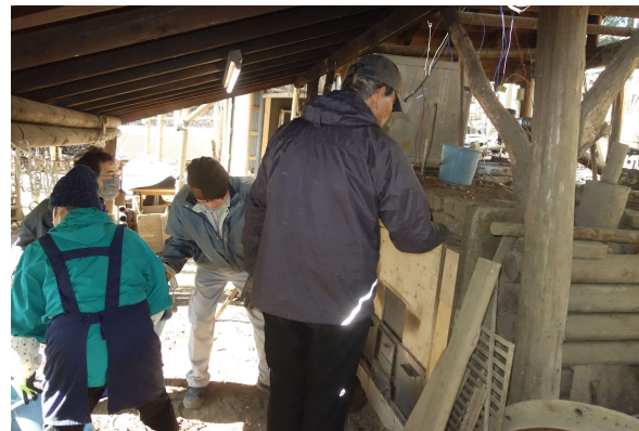
前面 蓋を閉じた後、空気の完全遮断の為、土 留め板と蓋の間に土を入れる バケツリレー
