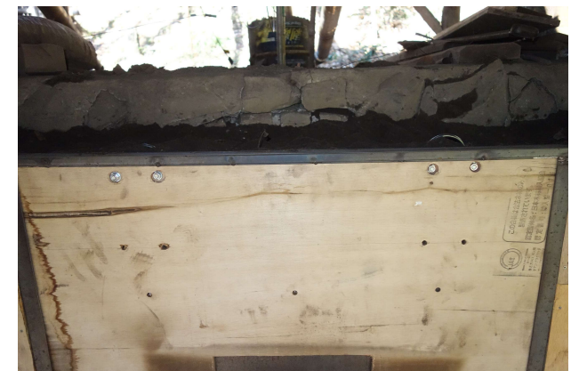
取手をボルト締めしていたナットに“ざぐり”加工して、引き上げ時に干渉しないよう対策
