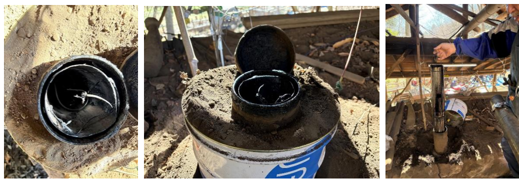
A 追加挿入した新品煙突缶の設置状態
